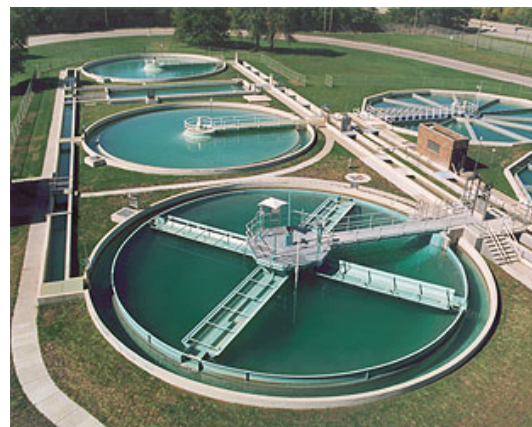
Le chlore est toujours utilisé dans plusieurs usines de traitement d'eau
